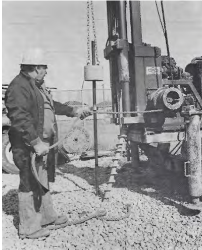
Πρότυπη δοκιμή διείδυσης (SPT). Σφύρα Donut, σχοινί και τροχαλία
