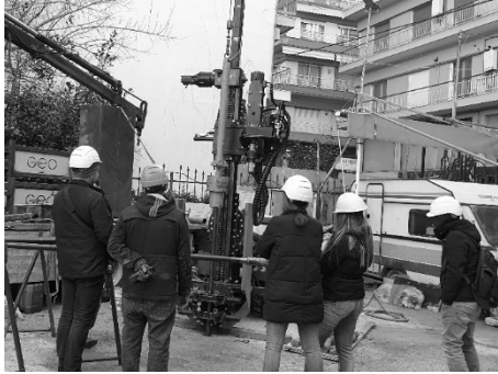
Εργασίες εδαφοτεχνικής έρευνας στην πόλη
