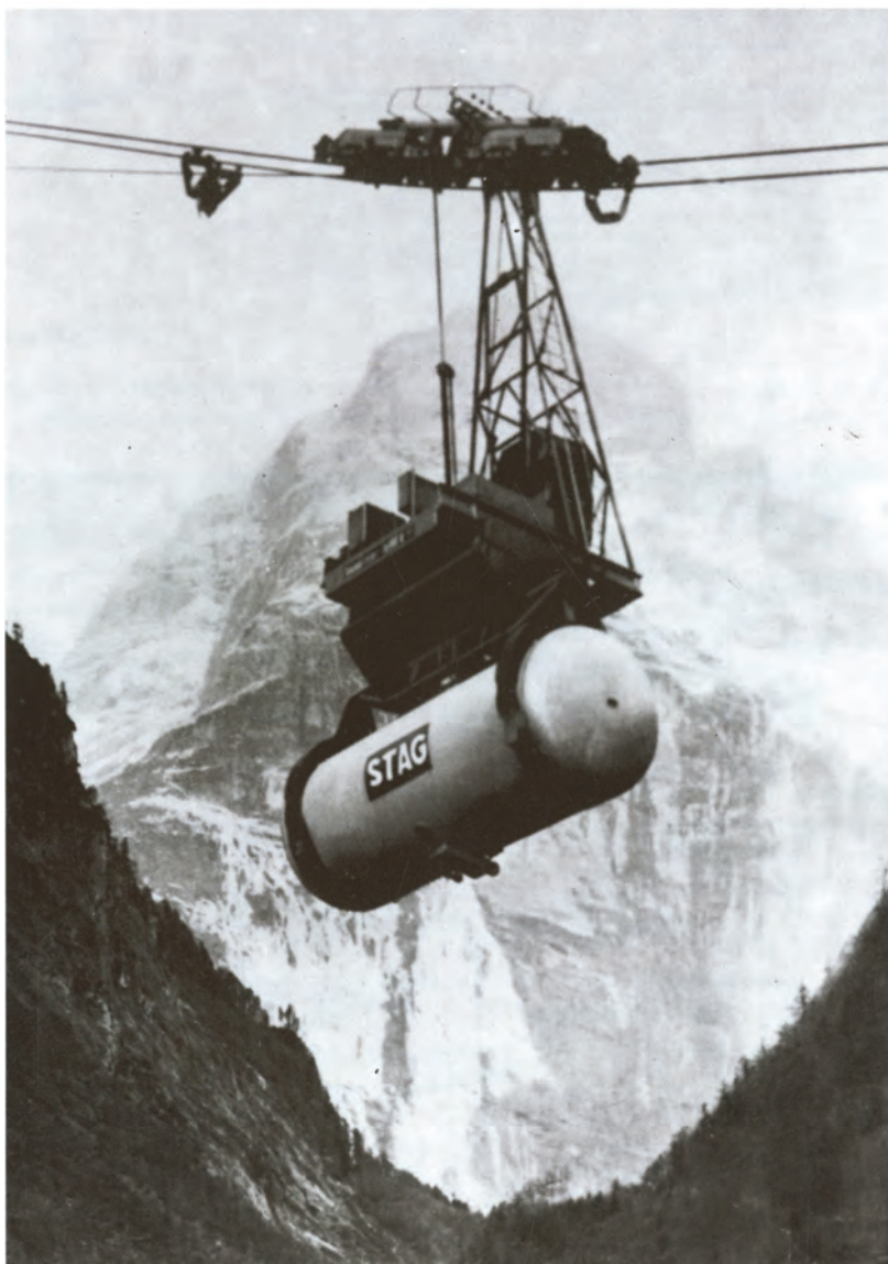
Υδροηλεκτρικό έργο Limmernboden της Ελβετίας. Μεταφορά 16 τόνων τσιμέντου με αερογέφυρα ( Schweizerische Talsperrentechnik, 1970 ).
